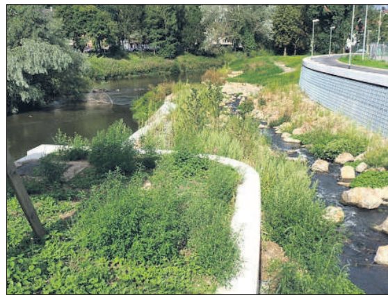
Blickt man am Hækkerwehr hinter der Galerie Stihl Waiblingen der Rems entlang in Richtung Neustadt, lassen sich die beiden Flussareale deutlich erkennen: links die Rems in ihrem Flussbett, rechts ein Abschnitt des Umgehungsgerinnes für die Fische. Foto: Greiner
