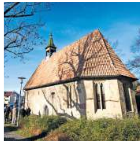
Die Siechenhauskapelle von 1473 Foto: Stoppel
