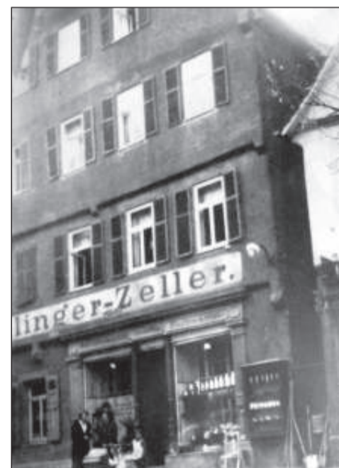
Das Gebäude noch mit kleinem Schaufenster.
