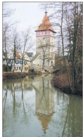
„Vorbildlich sanierter“ Beinsteiner Torturm – das bestätigt der Heimatverein der Stadt. Foto: David
