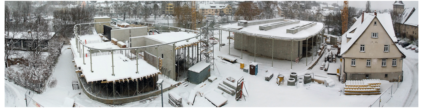
Im Januar 2007 fotografierte Daniela Döhring bei Wind und Wetter den Rohbau der neuen Galerie Stihl und der Kunstschule
